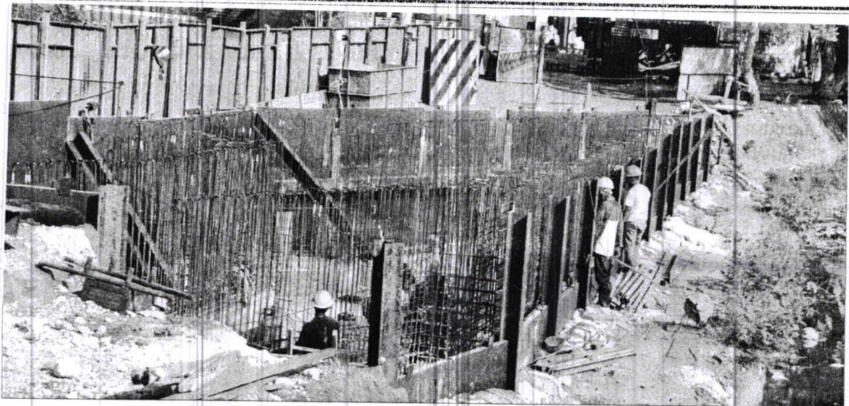
BALAPAN DENGAN HUJAN: Pembangunan pompa air raksasa di Jalan Dewi Sri, Legian, Kuta. Proyek ini dibangun untuk mengantisipasi terjadinya banjir di Legian, Kuta.
