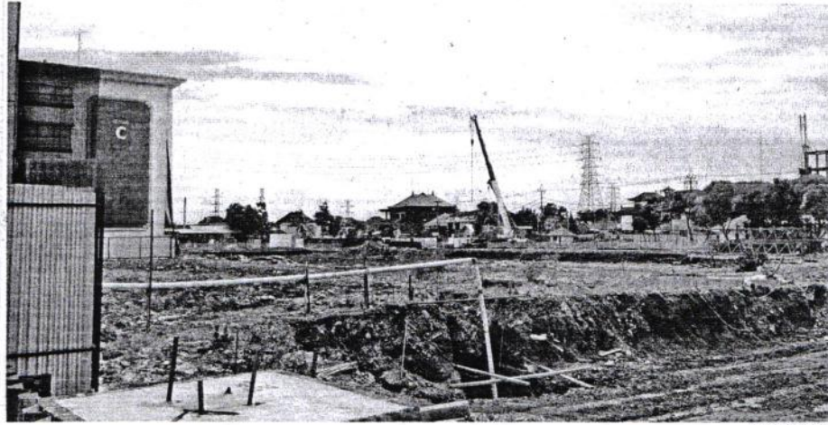
MULAI DIKERJAKAN - Kondisi lahan di RSUD Mangusada yang sudah diratakan dan akan dibangun gedung D, F dan G, Sabtu (26/1)
