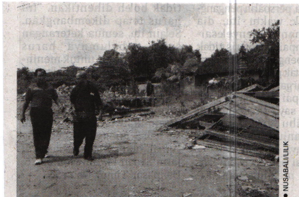
KANTOR Camat Sukasada yang diratakan tanah, untuk dibangun kantor baru dengan anggaran Rp 3,1 miliar.
